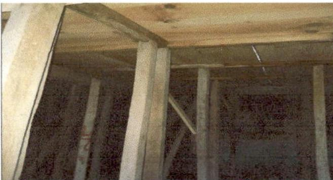
Foto 3: COCINA AVANCE FORMALETA DE FUNDICION DE SUSTITUCION DE TECHO DE LAMINA POR TECHO DE LOSA
