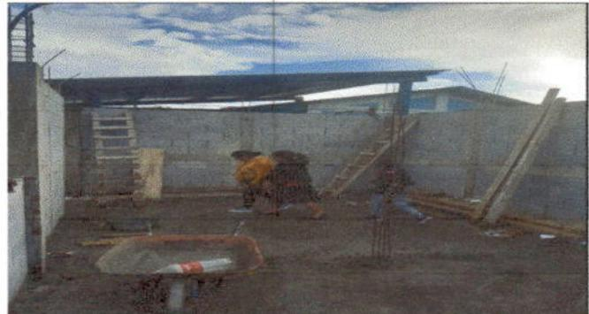
Foto 2: COCINA OTRA PERSPECTIVA DEL AVANCE DE SUSTITUCION DE PAREDES LAMINA POR PAREDES DE BLOCK
