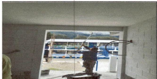
Foto 6: COCINA PINTADO DE BASE DE LA SUSTITUCIÓN DE LA PUERTA DE MADERA POR PUERTA DE METAL
