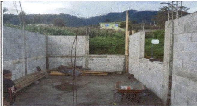
Foto 1: COCINA AVANCE DE SUSTITUCIÓN DE PAREDES DE LAMINA POR PAREDES DE BLOCK
