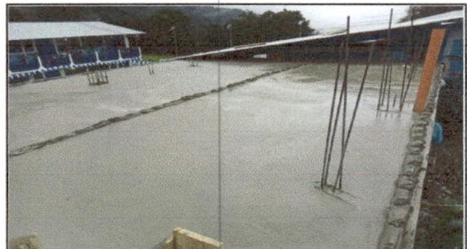
Foto 4: COCINA SUSTITUCION DE TECHO DE LAMINA POR FUNDICION DE TECHO DE LOSA
